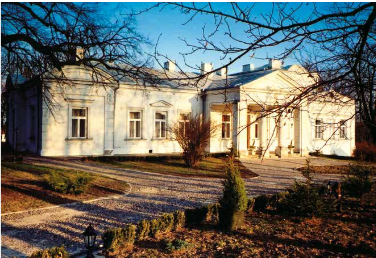
Dzierżnia. Dworek Rudnickich z 2 poł. XIX wieku, elewacja frontowa, stan obecny.
