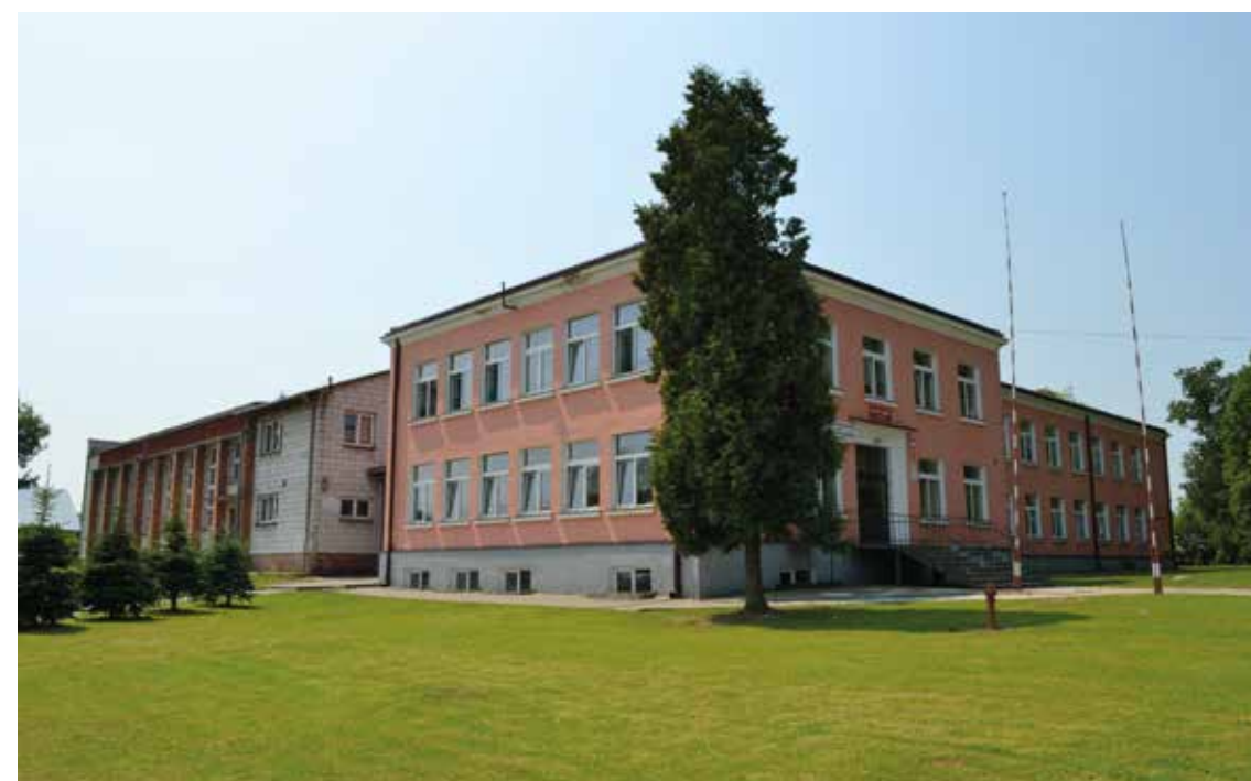
Krynice. Budynek Zespołu Szkół.
