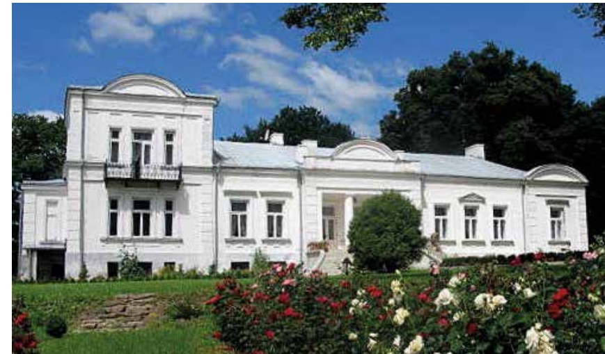
Dzierżnia. Dworek Rudnickich z poł. XIX wieku, elewacja ogrodowa, stan obecny.
