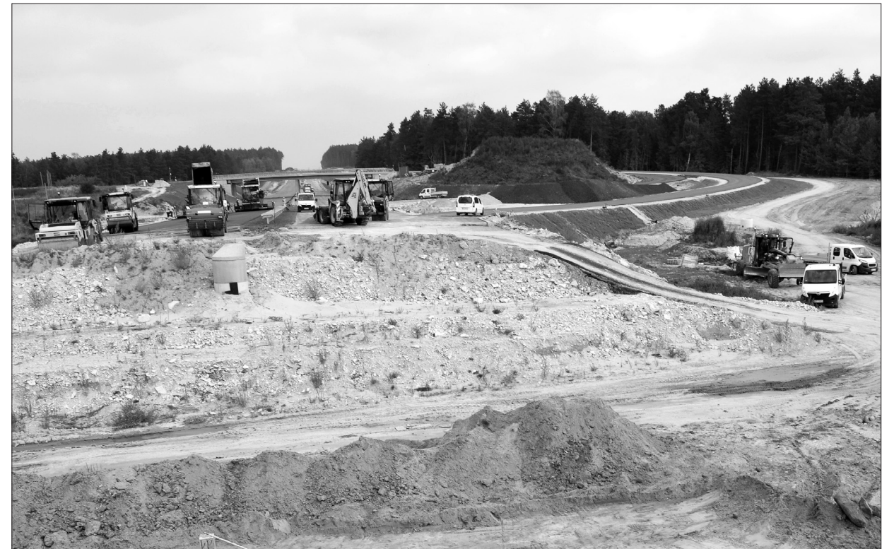
Jeziernia, końcowy etap budowy drogi ekspresowej S17.
