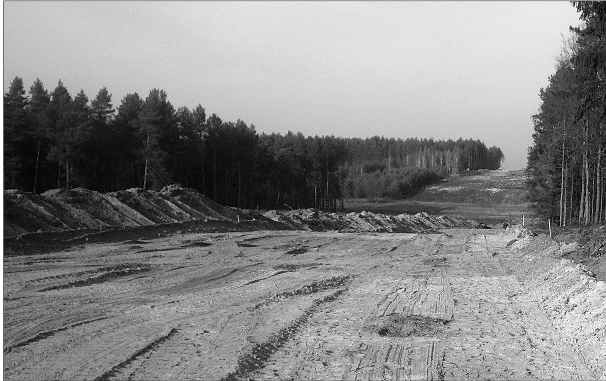
Kolonia Łaszczówka, początek budowy drogi ekspresowej S17.
