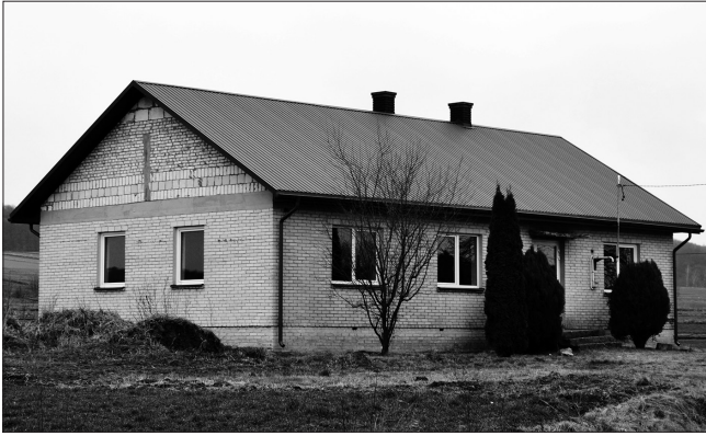
Ryc. 95. Świetlica Wiejska w Klekaczu, widok z 2020 roku.
