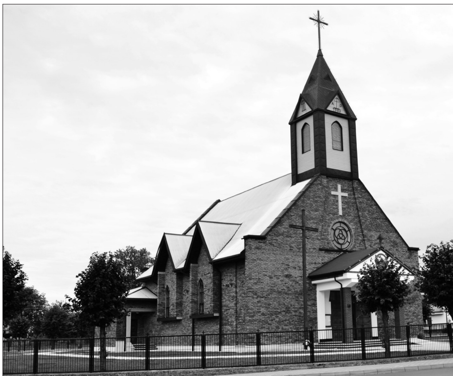
Ryc. 122. Łaszczówka, kościół p.w. Św. Trójcy, widok z 2019 roku.
